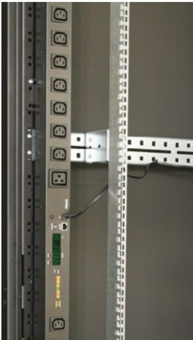
Ces produits offrent une combinaison de prises, dont des prises aux normes nationales associées à des prises industrielles, des entrées à fort ampérage et des modèles monophasés ou triphasés. Les prises d'entrée monophasées standards sont de type EN60309 16 A et 32 A ou de type IEC-C20 ou Schuko/UTE qui sont aussi dimensionnées pour 16 A ; les prises d'entrée triphasées standards sont de type EN60309 3x16A.
